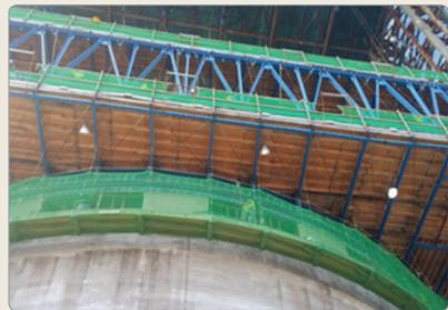
슬립폼 안전난간대 및 행인데크 안전망 설치
