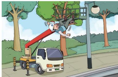
가로등 도장작업 후 작업대 탑승한 채 내려오던 중 인접 가로수에 하부가 접촉하여 그 충격으로 안전난간 해체된 단부로 떨어짐
