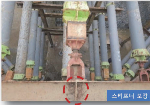
띠장 설치 및 버팀보 설치
