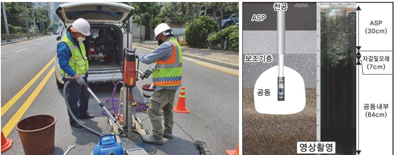
[그림 3.7] 공동예상지점 천공 전경(좌) 및 공내영상촬영 모식도(우)(예시)
